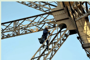
Korrosionsschutzarbeiten am Eiffelturm Quelle: bayferrox
